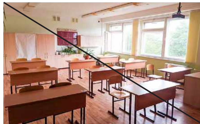
Плохо Линолеум под дерево
