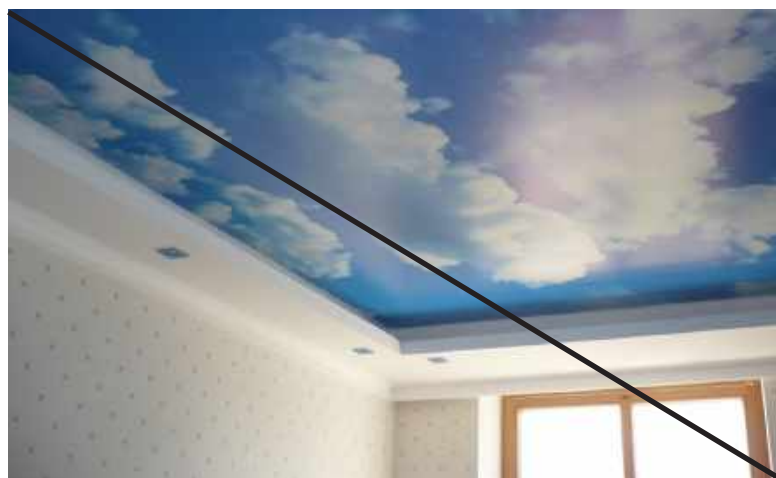
Плохо Натяжные потолки. Потолки с рисунками
