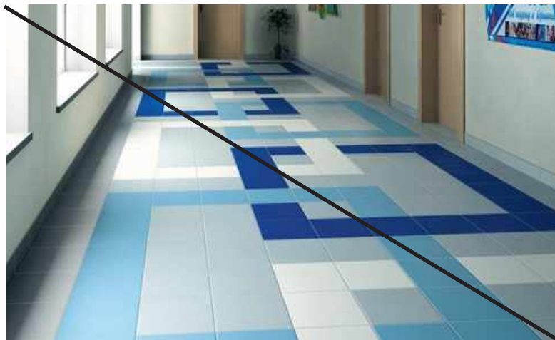
Плохо Цветные вставки из плитки
